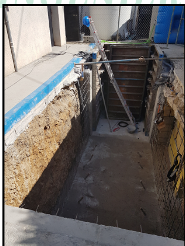
CONSTRUCCIÓN DE ALJIBE PARA ES TAMOIL RINCON DE LA VICTORIA
