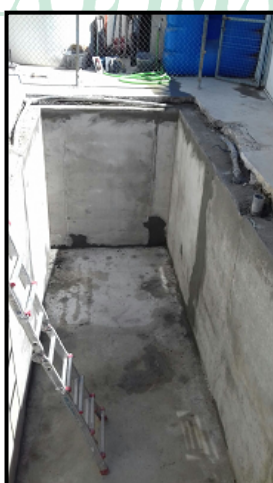
CONSTRUCCIÓN DE ALJIBE PARA ES TAMOIL RINCON DE LA VICTORIA
